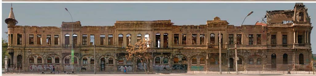
Antes y después, restauración de fachada cervecería Ebner. Archivo Municipalidad de Independencia.
