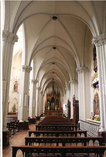
Vista de una de las naves laterales de la iglesia. Fotografía de Loreto Vergara Gálvez, en Arquitectura Patrimonial de Independencia , 2018.
